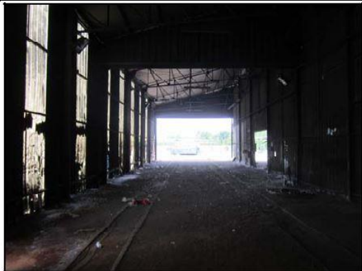
Figure 4 : Vue de l'atelier de décapage / sablage (14)
